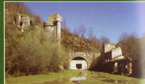
Túnel de La Engaña
